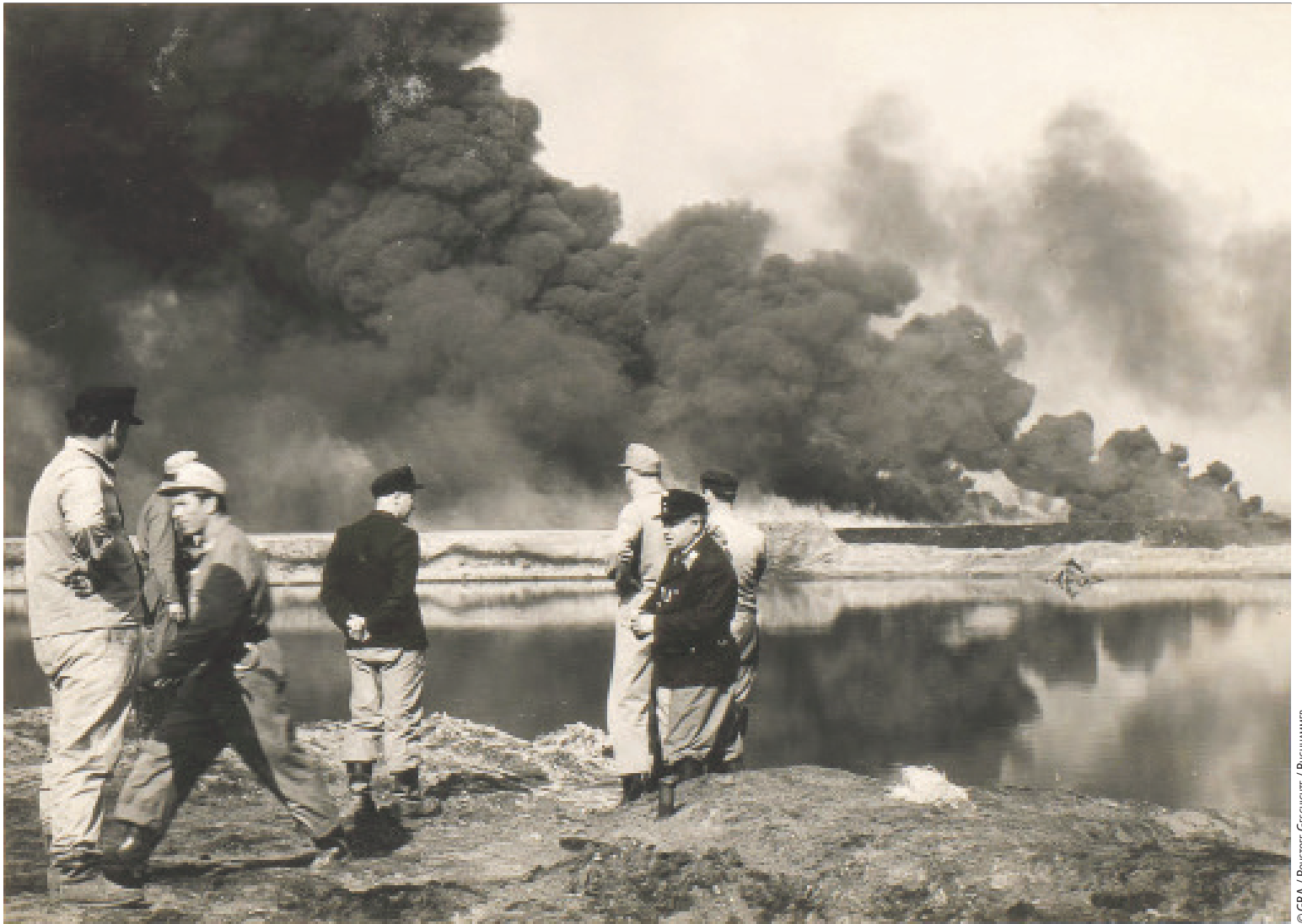
Kontrolliertes Abbrennen des Ölkraters von Matzen 9 im Jahr 1959
